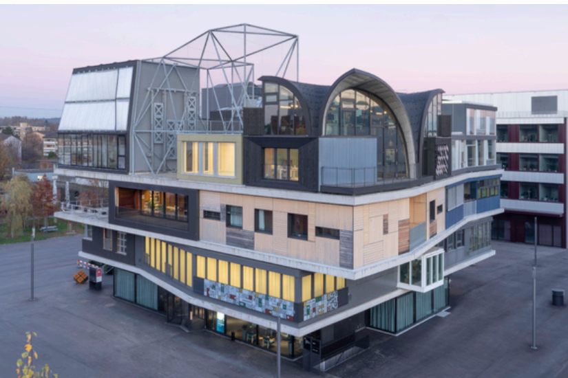
NEST 无人机中心 | 图片: ROK Architects
